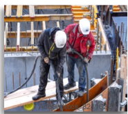
Chutes de hauteur
